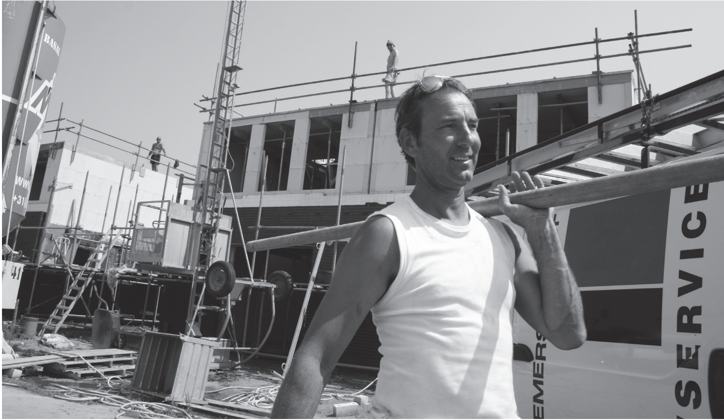
Bouwen is maatwerk. De nieuwe structuurvisie Wonen gaat uit van maatwerk. Foto: Gemeente Nederweert
