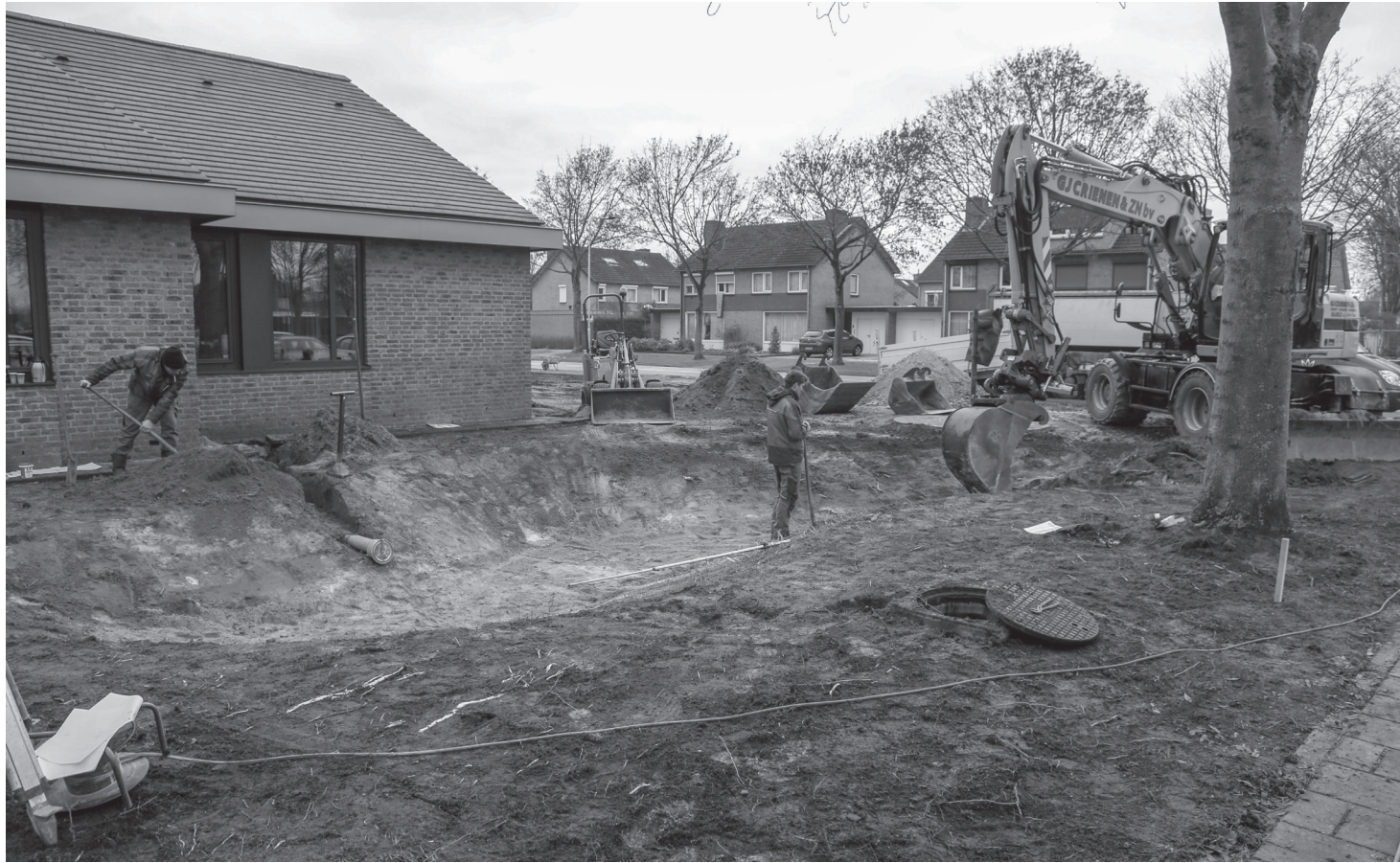
Rond (een deel van) het gemeentehuis leggen we een klimaatbestendige groenvoorziening aan. De wadi's gebruiken we om het regenwater van het dak op te vangen. Foto: Nederweert24
